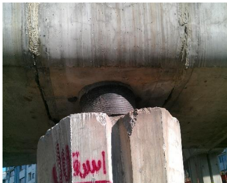
Figura 1-27: Applicazione dell'isolarti LRB in ponte di autostrada Sadr a Teheran
