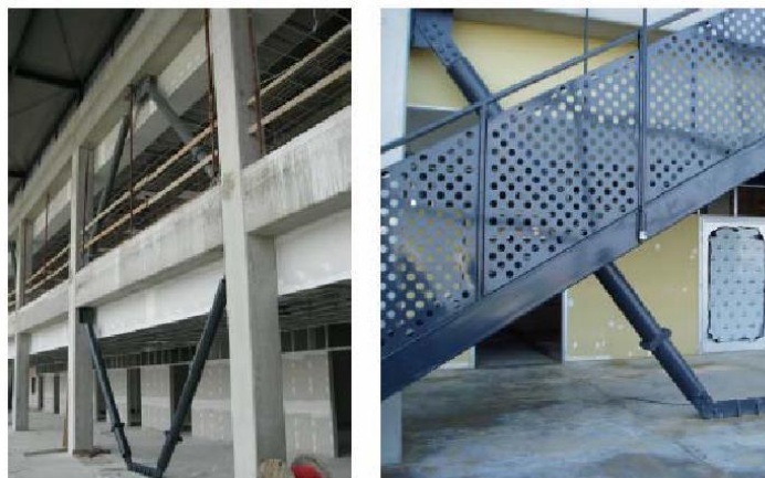
Figura 1-36: Dispositivi BRB installati all'Università di Ancona
