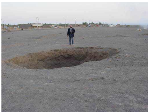
Figura 3-39: Sprofondamento dovuto al collasso di un Qanat ad ovest di Baravat
