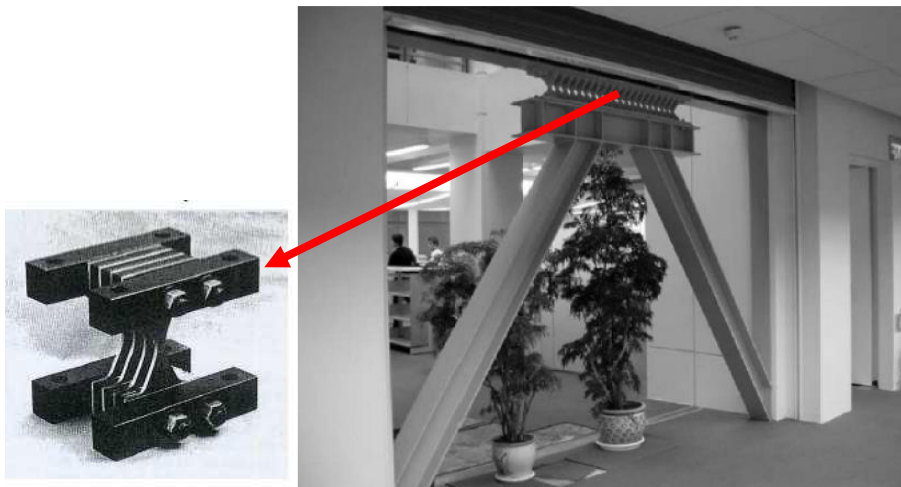
Figura 1-37: Dispositivi Isteretici X-shaped in una struttura
