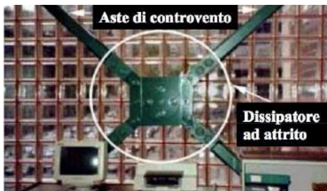
Figura 1-39: Esempio di applicazione dei Pall friction dampers in Canada
