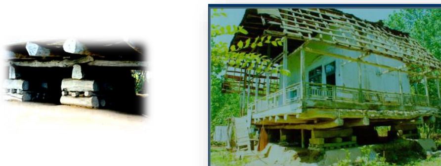
Figura1-5: Edificio residenziale in Masooleh (Nord Iran)
