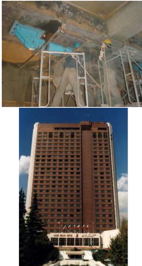
Figura1-43: Applicazione smorzatori viscosi nell'AZADI hotel a Teheran
