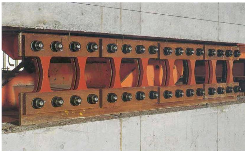
Figura 1-38: l'impiego di una serie di smorzatori metallici a piastra a forma di X
