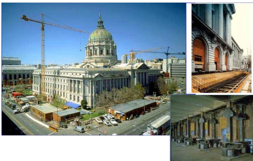
Figura1-30: Adeguamento sismico City Hall di San Francisco (Mediante 530 isolatori)
