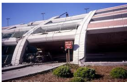
Figura 1-8: Collasso del parcheggio California State University a causa del terremoto di Northridge
