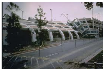
Figura 1-8: Collasso del parcheggio California State University a causa del terremoto di Northridge
