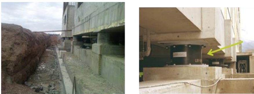
Figura1-32: Edifici residenziali nella Città di Parand con sistema isolamento alla base
