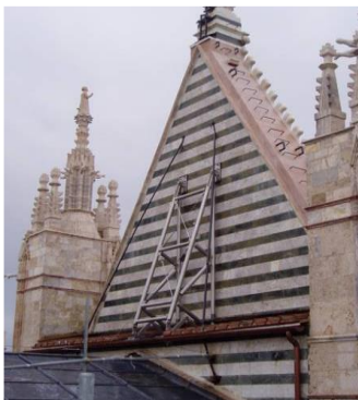
Figura 1-44: Duomo di Siena: Dissipatori viscosi ricentranti per evitare il ribaltamento della facciata
