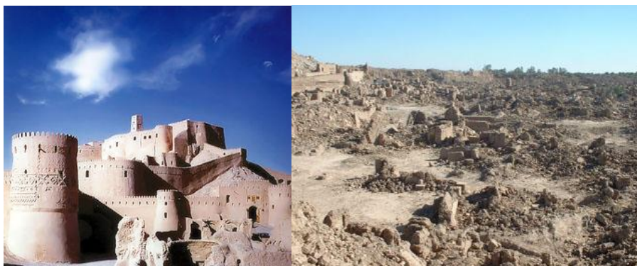
Figura 3-34: Arg-é Bam, prima e dopo del terremoto del 2003
