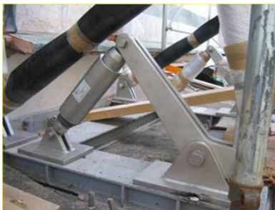
Figura 1-44: Duomo di Siena: Dissipatori viscosi ricentranti per evitare il ribaltamento della facciata
