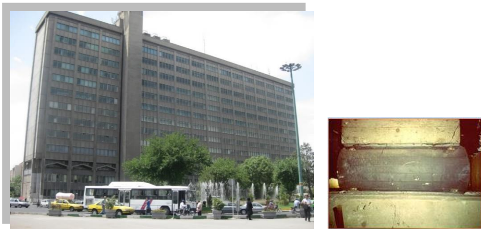
Figura 1-31: L'edificio delle telecomunicazioni di Tehran (1971)
